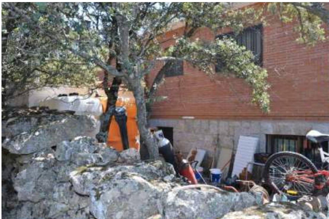
Fig 42. Acumulación de otros combustibles bajo la terraza
