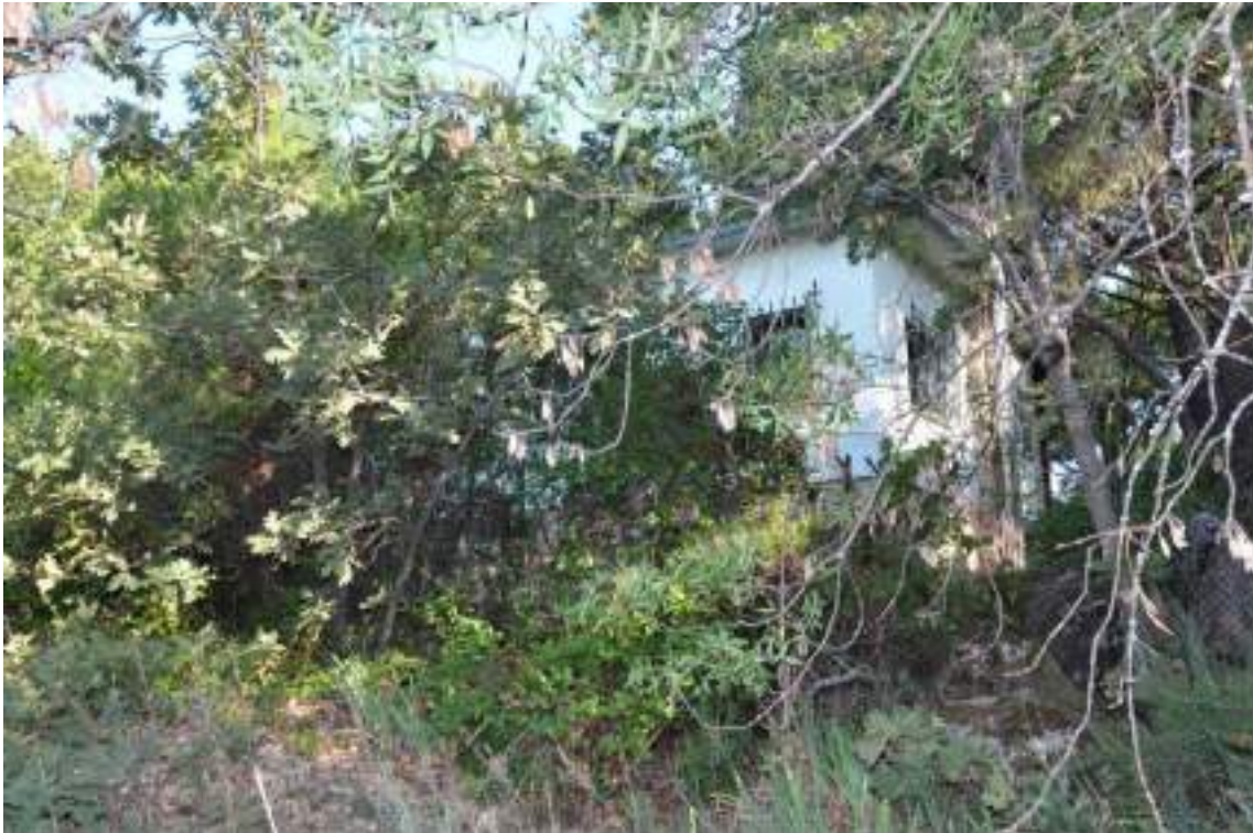
Fig. 34. Ejemplo de viviendas unifamiliares en el interior de la Urbanización Alcor rodeada de elementos combustibles. La copa del arbolado se ubica sobre el tejado de la vivienda.
